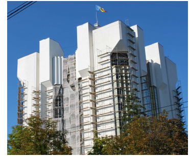
Clădirea Parlamentului în reconstrucție, foto Vizavi
